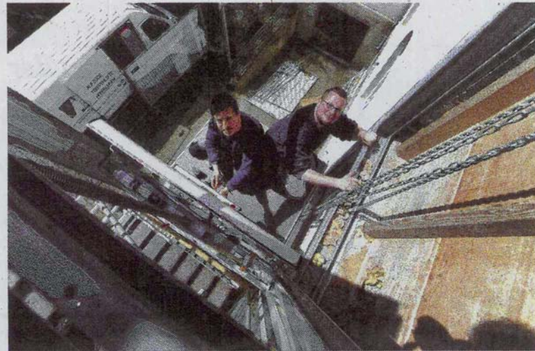
Pedro Pinto (li.) und Hermann Eickholt („Ammann & Rottkord“ aus Telgte) bringen am den neuen Aufzug am Amtshaus Gerthe an.
