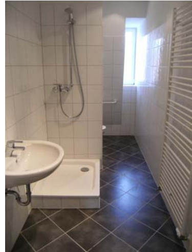
Abb. 6 Blick in das Badezimmer mit flacher Duschtasse auf niedrigem Duschsockel
