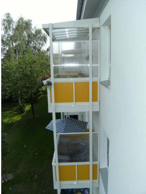
Abb. 8 Angebaute Balkone mit Überdachung
