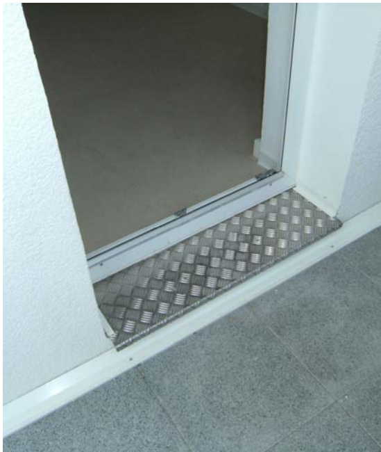
Abb. 9 Trittstufe beim Übergang zum tieferliegenden Balkon
