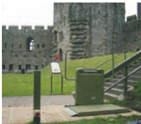
Außeninstallation auf Pfosten. Fährt auf Neigung neben der Treppe. Schloß, Großbritannien.
