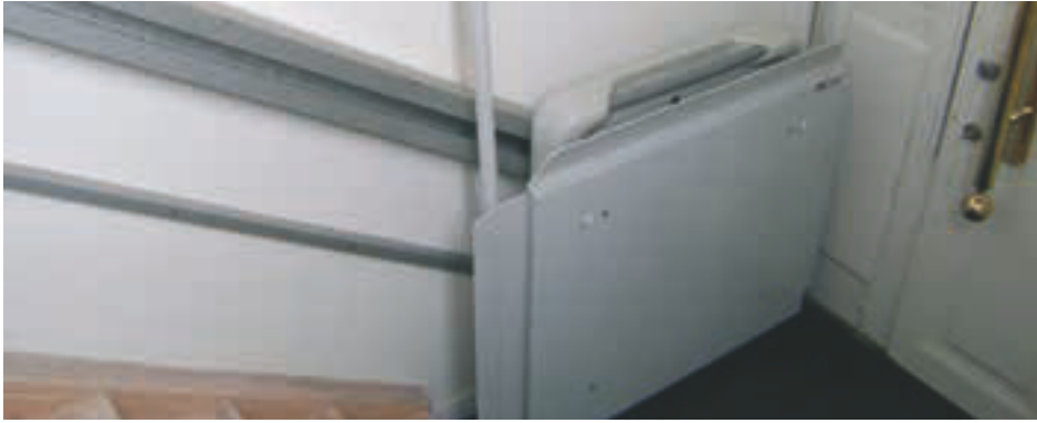
Inneninstallation, geparkt und zusammengeklappt, wenig Platz unten der Diele.
