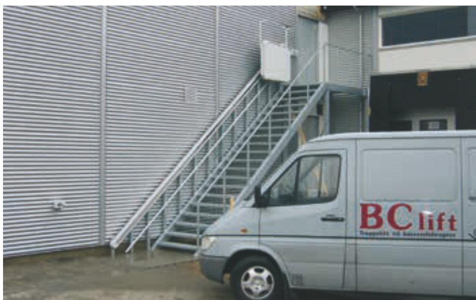
Außeninstallation auf Pfosten. Lager, Dänemark.
