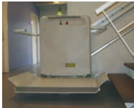
Inneninstallation mit einem Fußweg durch den Flur, was zu begrenztem Freiplatz im Flur führt. Nach Gebrauch wird der Lift zusammengeklappt und den Treppen entlang hochgefahren umgeparkert zu werden.
