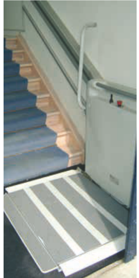
Eingang zum Lift mit seitlichem Zugang auf die Plattform.
