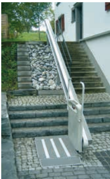
Außeninstallation auf Pfosten. Fährt auf Neigung neben der Treppe. Privat wohnung, Schweiz.
