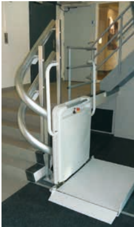
Inneninstallation 180 Grad Biegung nach unten. Niederlande.
