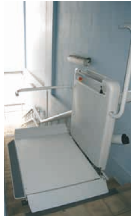
Außeninstallation, über horizontalen Treppenabsatz gebogen. Singapur.
